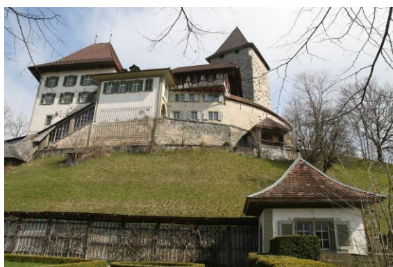
Ansicht von Süden, Höhe Schlossgarten
