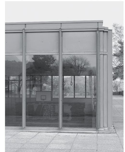
Detail der Turnhallenfassade nach der Dachsanierung. Foto 2009 (ESM).
