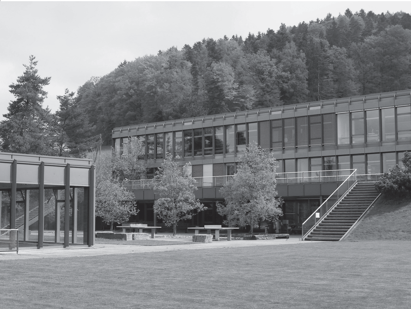
Klassentrakt nach der Dachsanierung. Links im Vordergrund die zur Hälfte eingetiefte Turnhalle. Foto 2009 (ESM).
