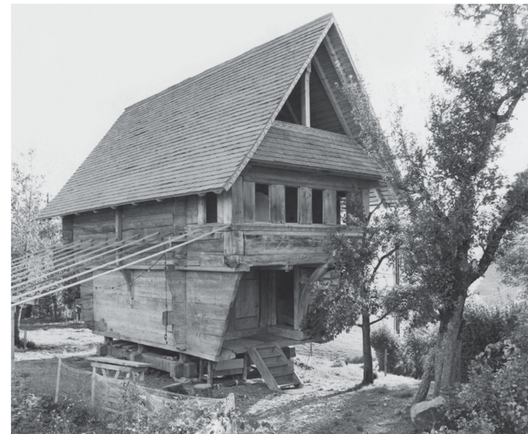
Gesamtansicht des restaurierten Speichers. Foto 1998 (JG).
