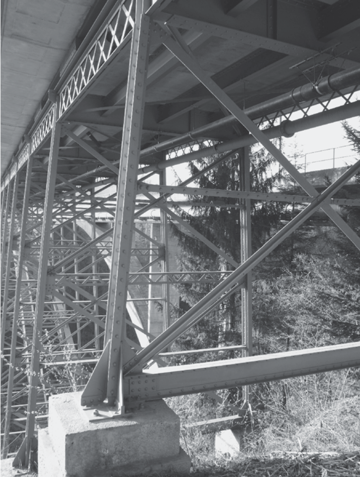
Detail der Stahlkonstruktion mit neuer Brückenplatte von 2004. Foto 2010 (PB).
