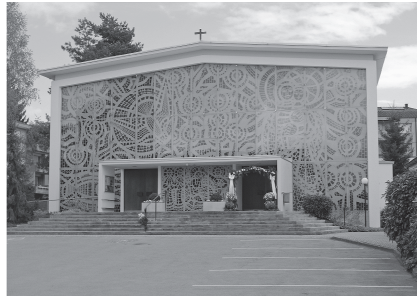
Hauptfassade der Kirche mit 2004 vorgestellter Glasfassade. Foto 2009 (PB).
