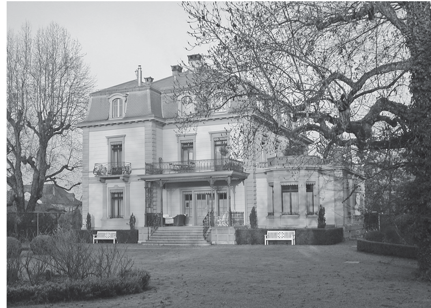
Die Hauptfassade der Villa mit dem Anbau von 1892 (rechts). Die Veranda entstand 1904. Foto 2002 (Bernhard Kruppenacher).
