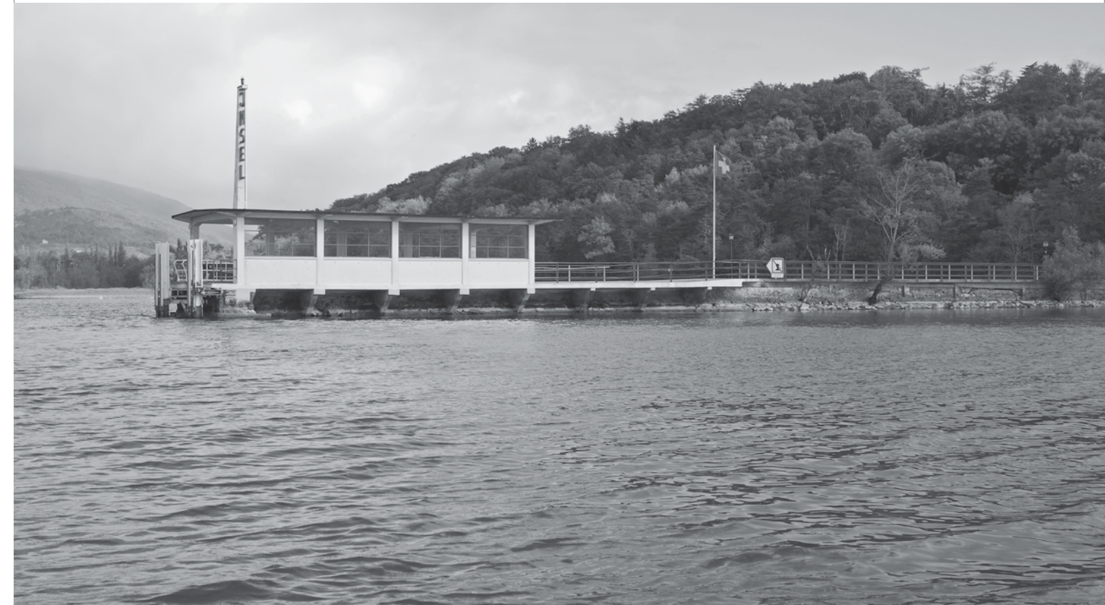
Wie ein Kahn weit draussen im See: der Landungssteg St. Petersinsel Nord nach der Restaurierung. Foto 2010 (VGM).
