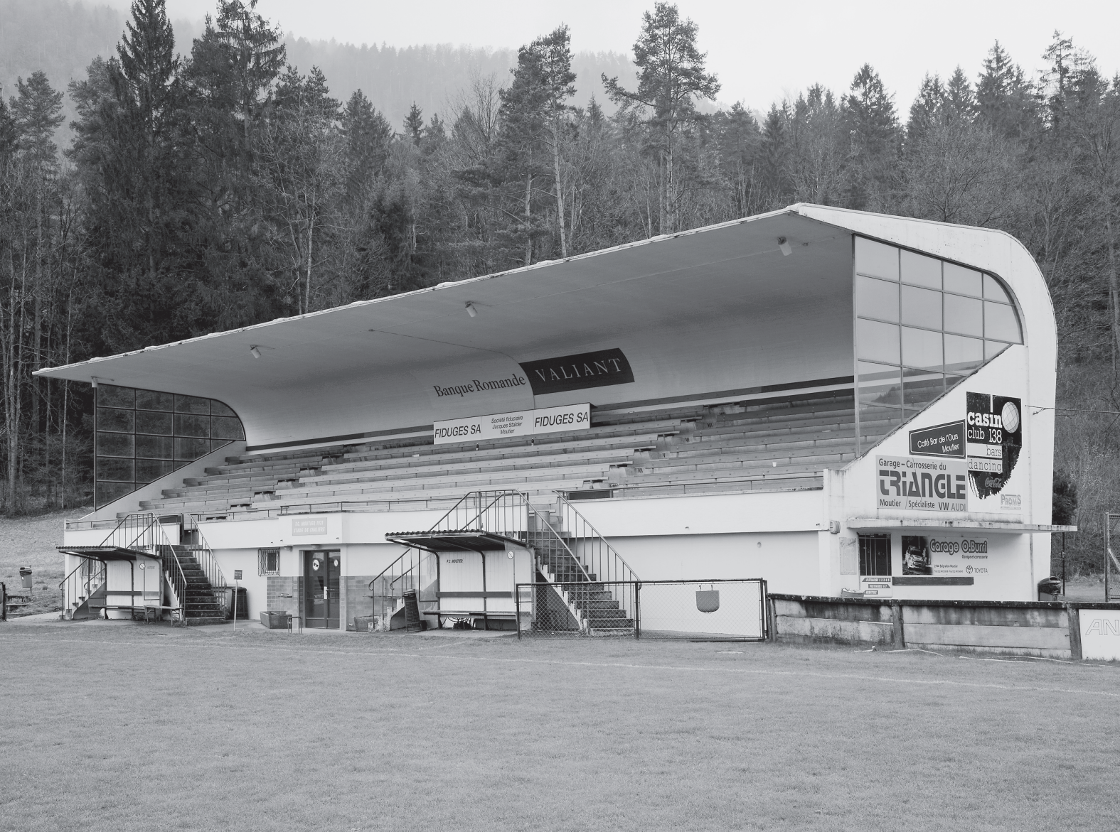
Tribune du stade de Chalière après la restauration. Photo 2010 (VGM).
